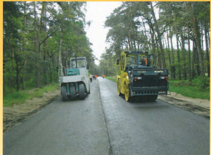
Bild 7: Verdichtung mit Gummiradwalze sowie Glätten mit Glattmantelwalze
