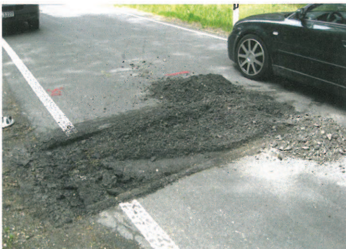
Bild 3: Probenahmestelle zur Entnahme von Asphalt und Schotter bis 30 cm unter Fahrbahnoberkante
