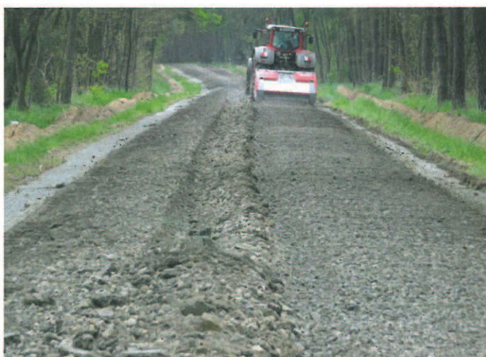
Bild 5: Mobiler Brecher beim Einsatz auf der Landstraße L 72
