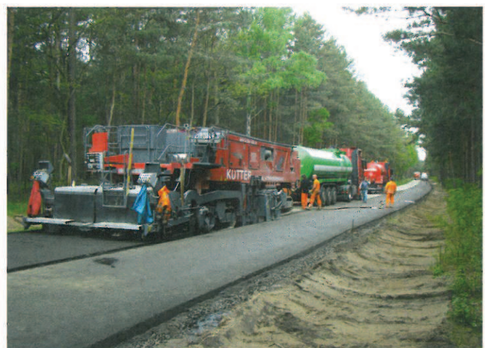
Bild 6: Herstellung der KRC-Schicht
