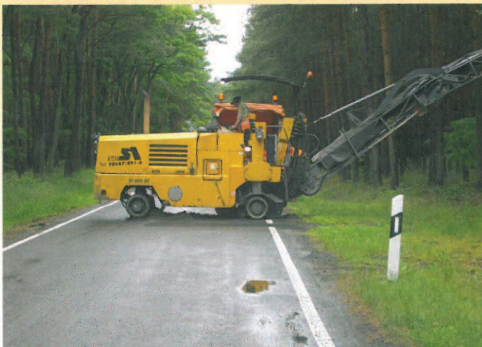
Bild 2: Auffräsen der Probenahmestelle auf der Landesstraße L 72
