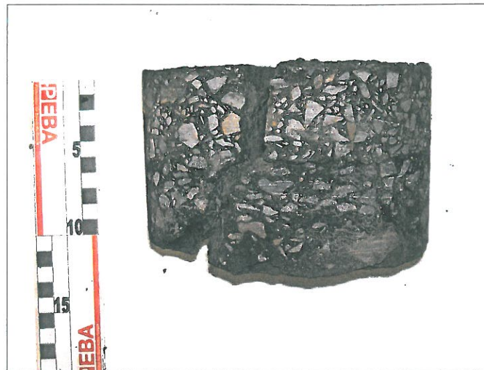
Bild 8: Bohrkern eines gerissenen Gussasphaltes
