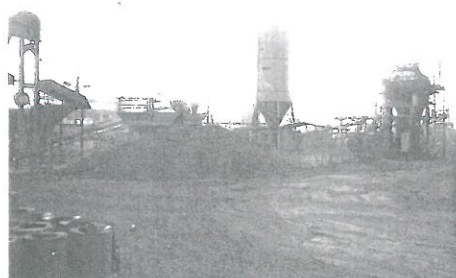
Bild 3: Wiederaufbereitungsanlage mit Brecher (Prallmühle), Siebanlage und Linhoff-Standkocher (12 t)
