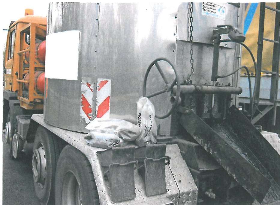
Bild 4: nicht erlaubte nachträgliche Wachszugabe in vorher bereits wachsmodifiziertem Gussasphalt (Quelle: Runge)
