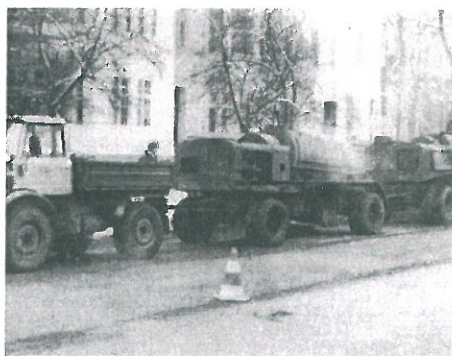
Bild 2: Kohlebeheizter 4-t-Motorkocher
