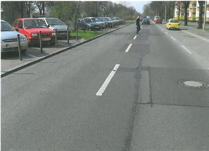
Bild 2: Die „Köpenicker Landstraße“ mit Rissen, die aus der Betontragschicht durchschlagen.
