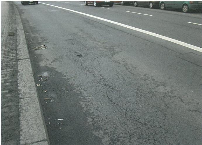
Bild 4: Die Fahrbahnoberfläche der „Südostallee“ mit deutlichen Alterungs- und Verschleißerscheinungen, überwiegend Netzzrissbildungen, einer grobrauben Oberfläche, Kornausbrüchen und Ermüdungsrissen.
