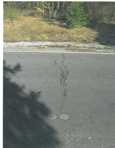
Bild 5: Die Fahrbahnoberfläche „OD Glau, Entnahmestelle 1“ mit geringfügigen Alterungs- und Verschleißerscheinungen, einzelnen Kornausbrüchen und geringer Nachverdichtung.
