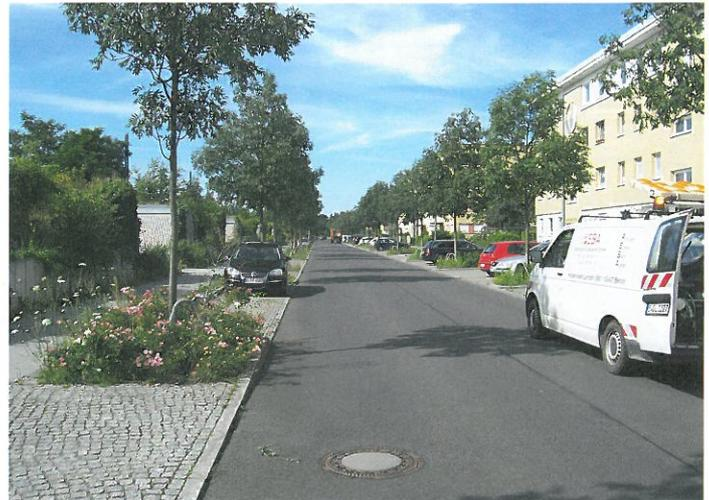
Bild 3: Die Fahrbahnoberfläche der „Lehmusstraße“ weist geringfügige Alters- und Verschleißerscheinungen und einzelne Kornausbrüche auf.
